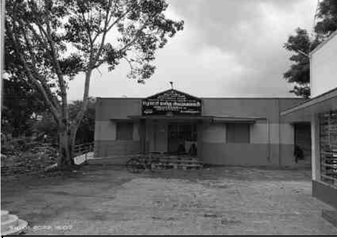
ஊராட்சி அலுவலகம், அப்பையநாயக்கன்பட்டி
